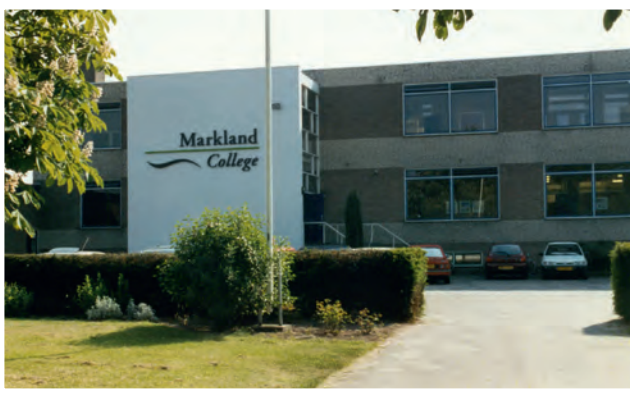
Nieuwbouw Markland College Zevenbergen. (Fotocollectie Markland College Zevenbergen)
