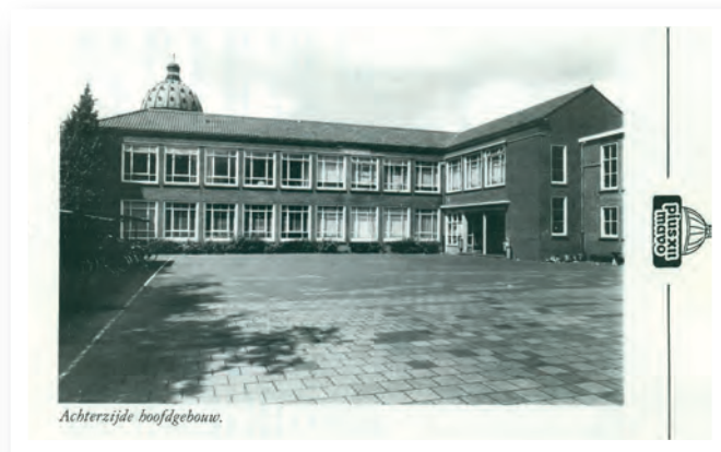
Achterzijde hoofdgebouw. De achterzijde van het gebouw van de Pius aan de St. Annastraat. Inmiddels gesloopt. (Fotocollectie Sint Anna)
