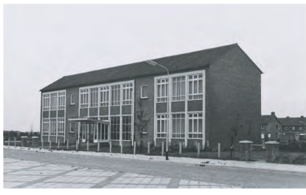
De Christelijke ULO-school in Zevenbergen, gebouwd in 1956. (Fotocollectie RAWB)
