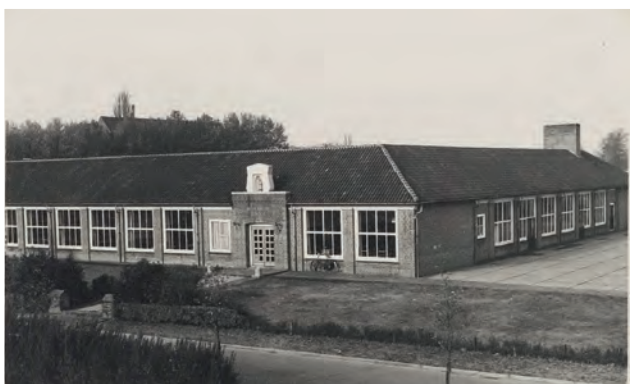
De voorgevel van de KTS aan de Pagnevaartweg in 1960. Boven de ingang staat het beeld van de H. Jozef, de patroon van de school. (Fotocollectie Regionaal Archief West-Brabant)
