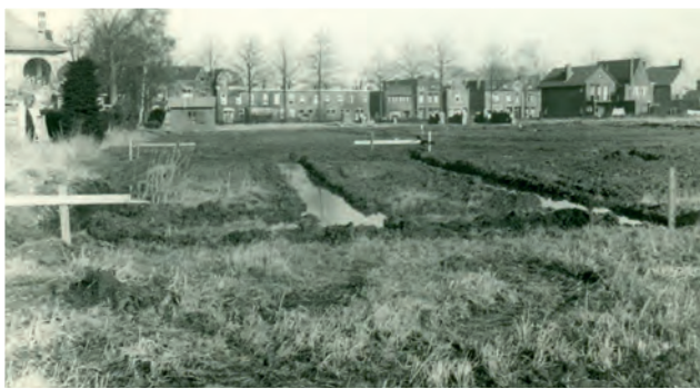
De funderingssleuven zijn in 1955 gegraven voor de houtbouw van de HBS, maar langdurige, hevig regenvol verhinderde dat ze gevuld werden met beton. Achteraan is de Bosschendijk zichtbaar. (Fotocollectie Markland College)
