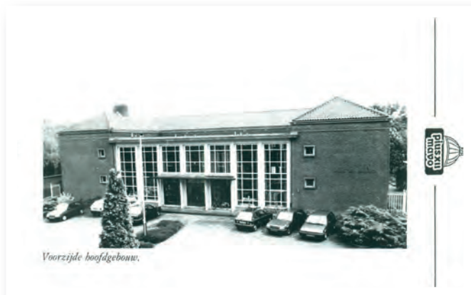
Voorzijde hoofdgebouw. De voorzijde van het gebouw van de Pius aan de St. Annastraat. Inmiddels gesloopt. (Fotocollectie Sint Anna)
